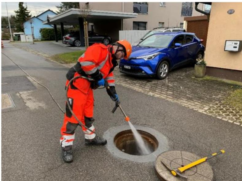
**Lavoratore:** eseguo la pulizia manuale di superfici o il lavaggio di un pozzetto esclusivamente con una pistola a getto o una lancia di pulizia. Utilizzo le lance di pulizia in modo corretto e non blocco il dispositivo di arresto.
